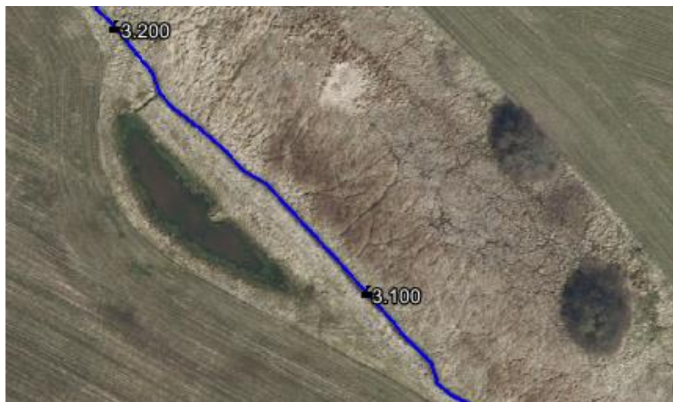
Figur 41: Et teknisk anlæg mellem st. 3.100-3.200 m i vandområde o4097.
